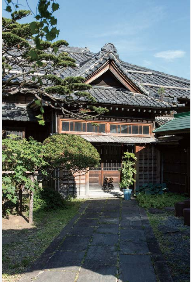
所在地／小樽市住吉町 4-9 建築年／明治 39 年（1906） 構造／木造 2 階建
